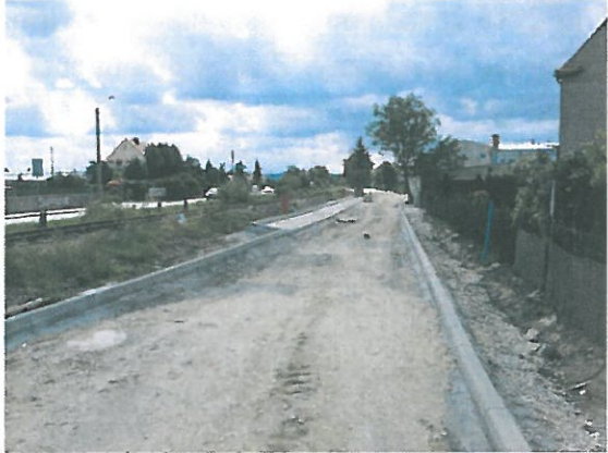
Zatoki wzdłuż ul. Chłopskiej w trakcie budowy
