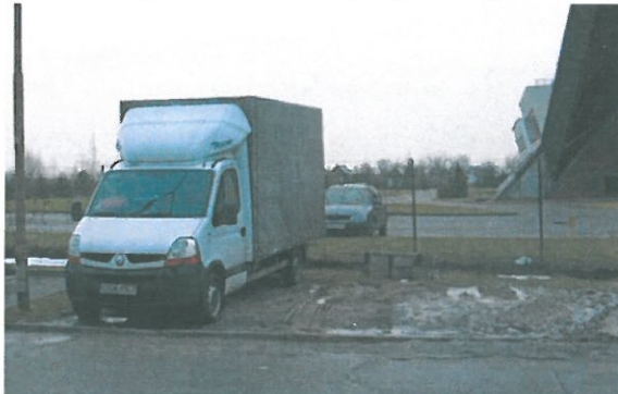
Teren przed wybudowaniem zatoki
