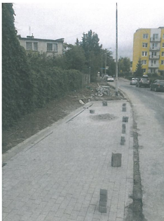
Zatoka ul. Paderewskiego – podczas budowy
