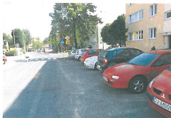
Gotowa zatoka przy ul. Kozara-Słobódzkiego
