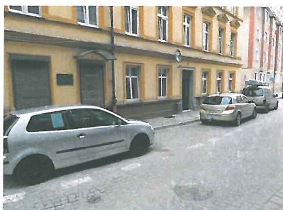
Ul. Spółdzielcza po przebudowie
