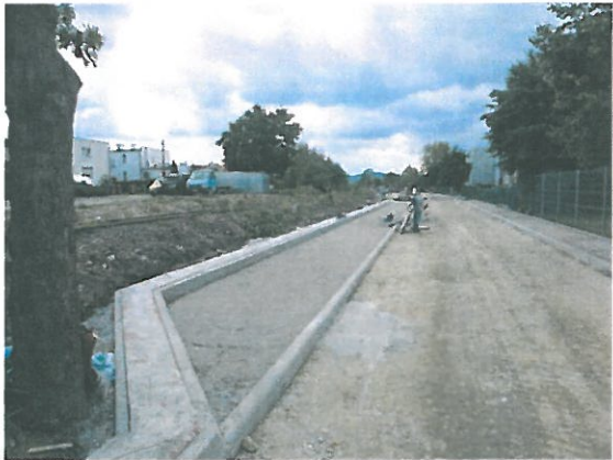
Zatoki wzdłuż ul. Chłopskiej w trakcie budowy
