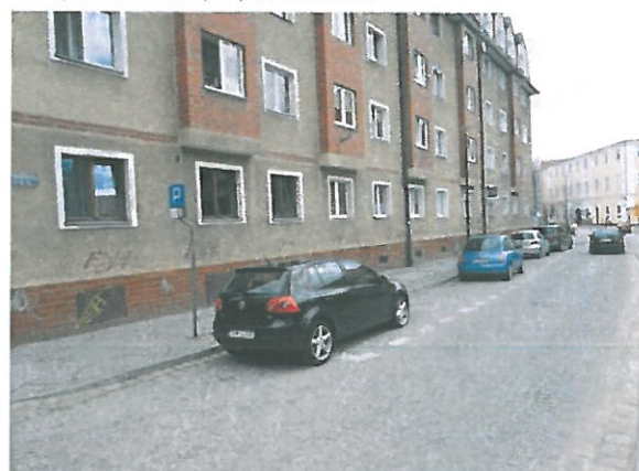
Ul. Spółdzielcza po przebudowie
