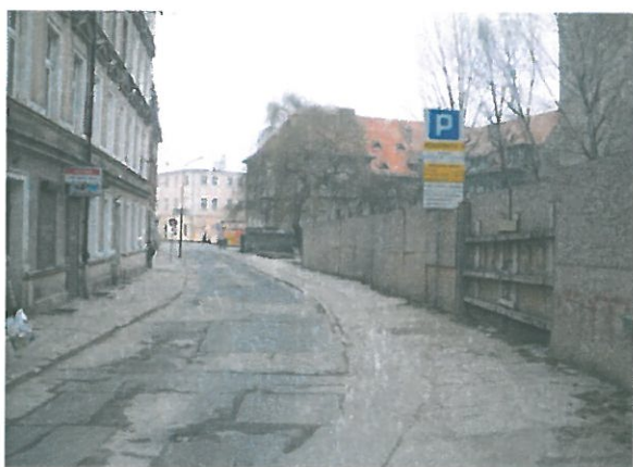
Ul. Spółdzielcza przed przebudową
