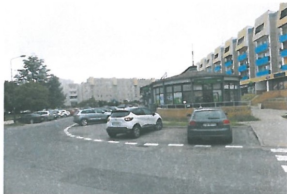
Gotowa zatoka przy ul. Jadwigi Śląskiej
