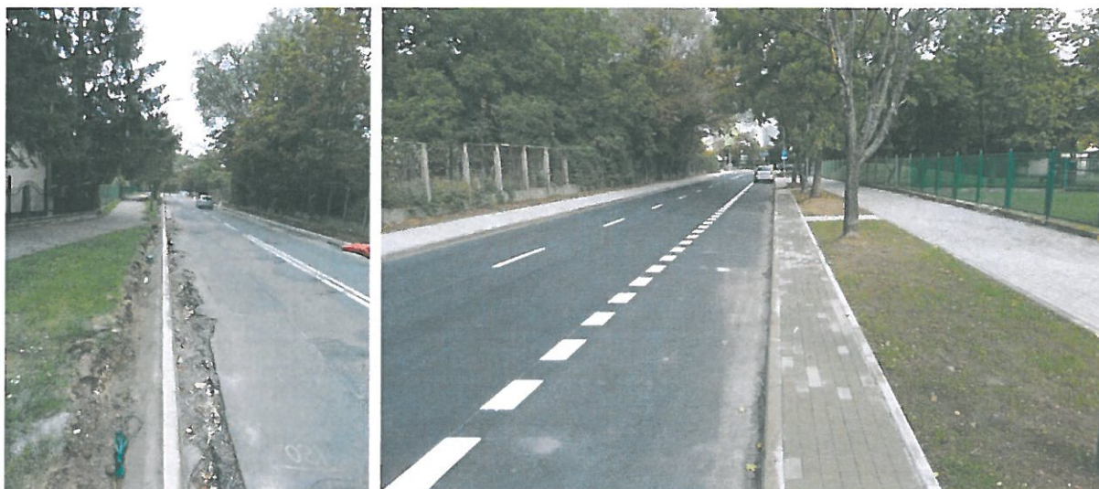
Zatoka przy ul. Sybiraków w trakcie budowy i po przebudowie
