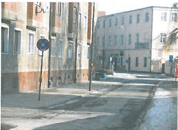
Ul. Spółdzielcza przed przebudową
