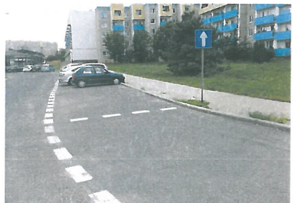
Gotowa zatoka przy ul. Jadwigi Śląskiej
