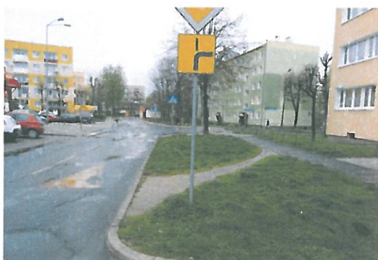
Teren przed wybudowaniem zatoki
